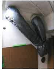
パウキャビン左舷側後方、ちょうど助手席の裏側の壁面にも送風口を設置。銀色のダクトを通して、本体から風が送られてくる。パウキャビンを使わないときは、この送風口は閉めている
