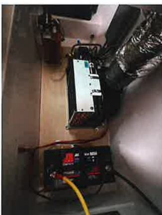
こちらはアクソパー 28キャビンでの設置例。ご覧のように、エアコン本体(中央)とDC12Vのバッテリー(手前)というシンプルな構成で使えるのもポイントだ
